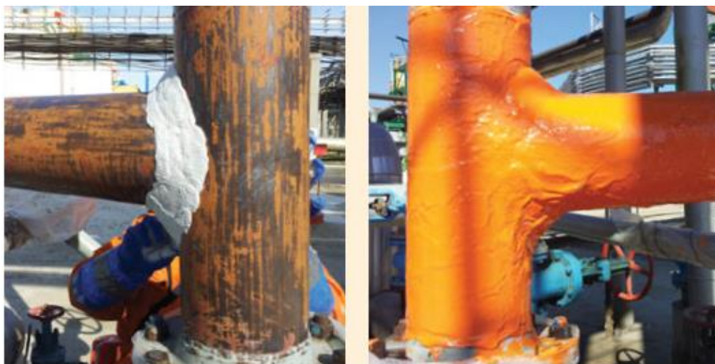
Рисунок 3.5 – Технология ремонта с применением композитной муфты ИНТРА КРМ
