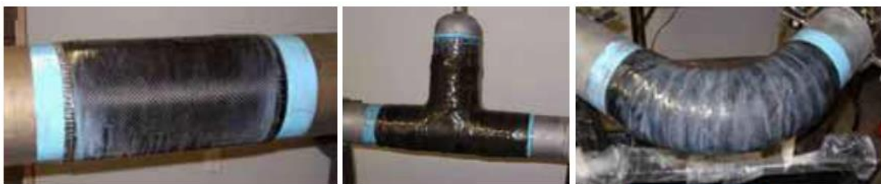
Рисунок 3.6 – Конструкции отремонтированные системой Black Diamond [16]
