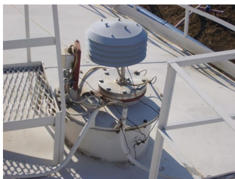
Рисунок 19 – Радарный уровнемер системы KOR-VOL NT
