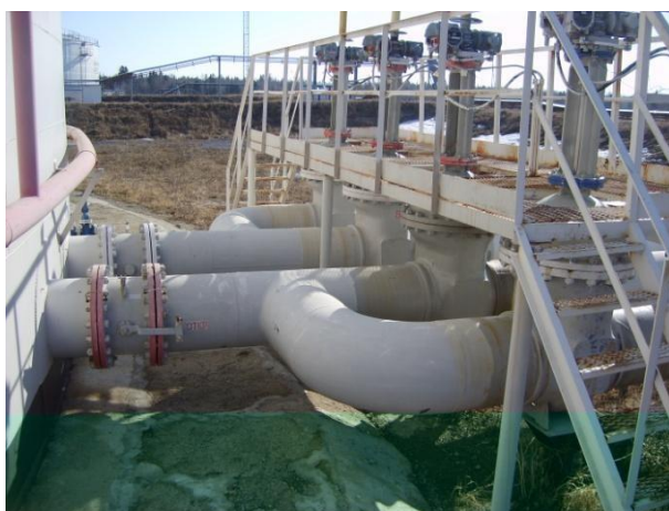
Рисунок 14 – Приемо-раздаточные устройства с коренными задвижками
