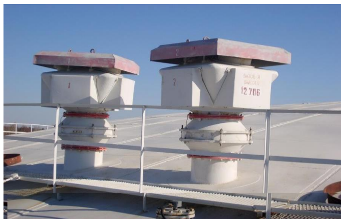
Рисунок 9 – Дыхательные клапаны КДС с огневыми предохранителями
