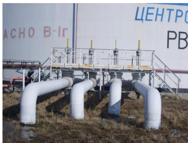
Рисунок 14 – Приемо-раздаточные устройства с коренными задвижками
