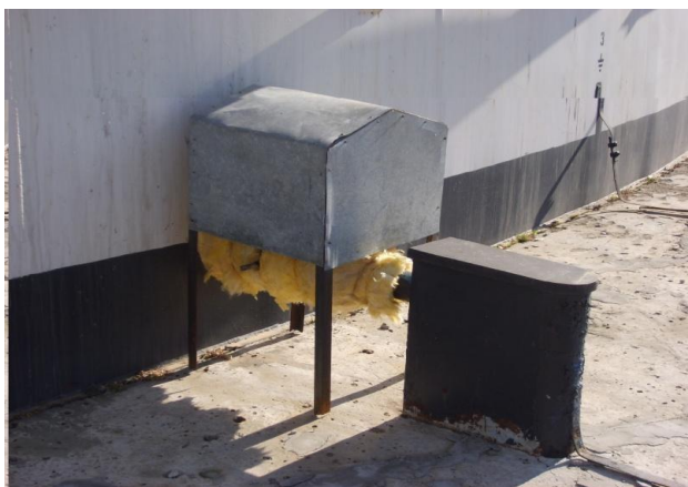
Рисунок 16 – Кран сифонный с кожухом
