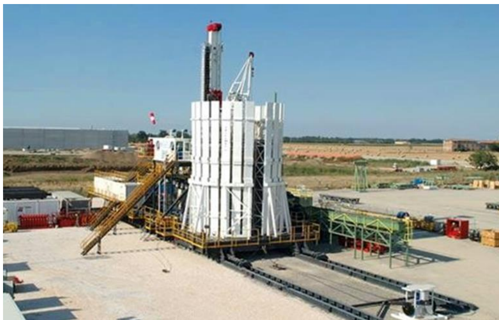
Рисунок 3.8 – Автоматизированная буровая установка гидравлического типа НН-300
