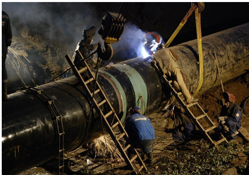
Рисунок 3.12 - Сварка стыка СТ.1 Ду 1200 на 2130,9 км МН «НКК»
