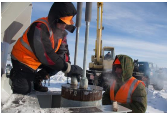
Рисунок 11 – установка термостабилизаторов в сваи опор нефтепровода
