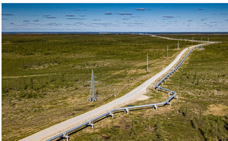
Рисунок 14 – Трапецевидный термокомпенсационный блок на нефтепроводе «Заполярье-Пурпе»
