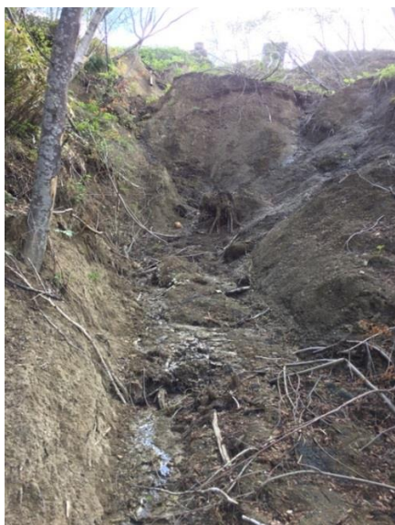
Рис. 3. Водоток под телом оползня Fig. 3. Watercourse under the landslide body
