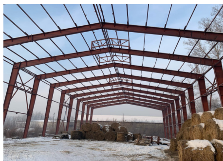
Рис. 2. Фото конструкций каркаса здания школы верховой езды в г. Абакане
