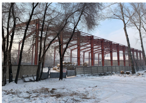
Рис. 1. Фото существующего каркаса здания школы верховой езды в г. Абакане
