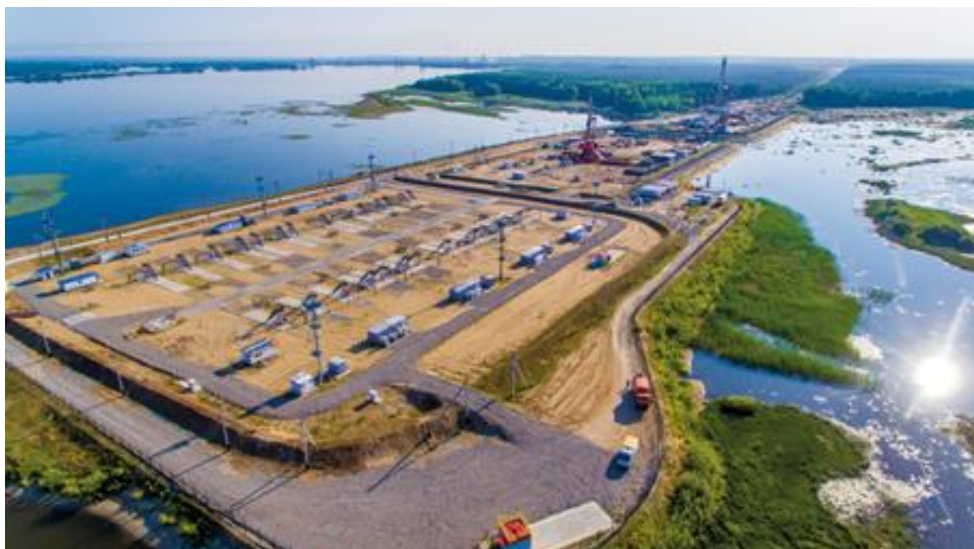
Рис. 1. Производственная площадка месторождения имени Сухарева
