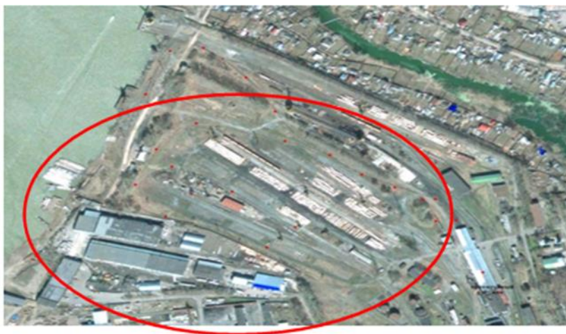
Рисунок 3 – Территория шпалопропиточного завода
