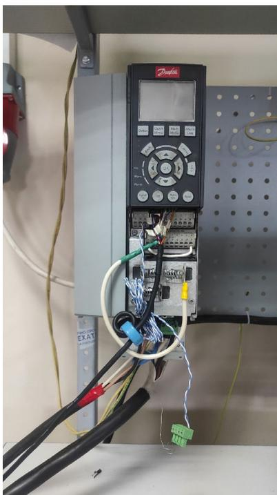
Рис. 45. Преобразователь частоты Danfoss
