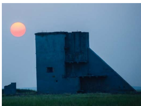
Рисунок 3 - Современное состояние приборного сооружения «букашка»
