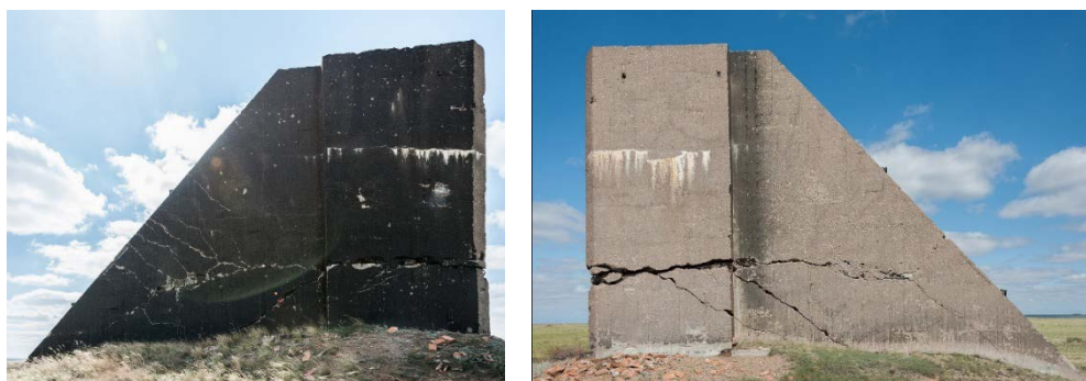
Рисунок 2 - Современное состояние приборных сооружений «аннушка»
