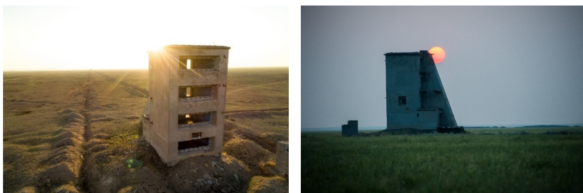
Рисунок 4 - Современное состояние приборных сооружений «верочка»
