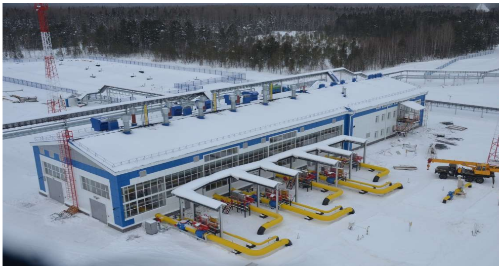
Рисунок 1.1 – Здание компрессорного цеха КС «Александровская»
