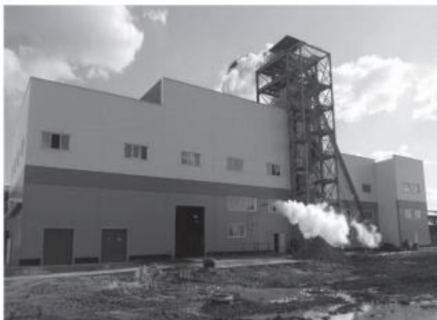
Рисунок 18 - Внешний вид здания стенда комплексных испытаний [38]
