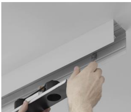
Рисунок 39 - Установка алюминиевого профиля
