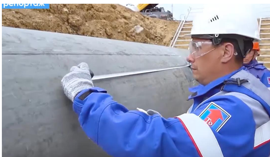
Рисунок 4 – Разметка необходимой области для ремонта
