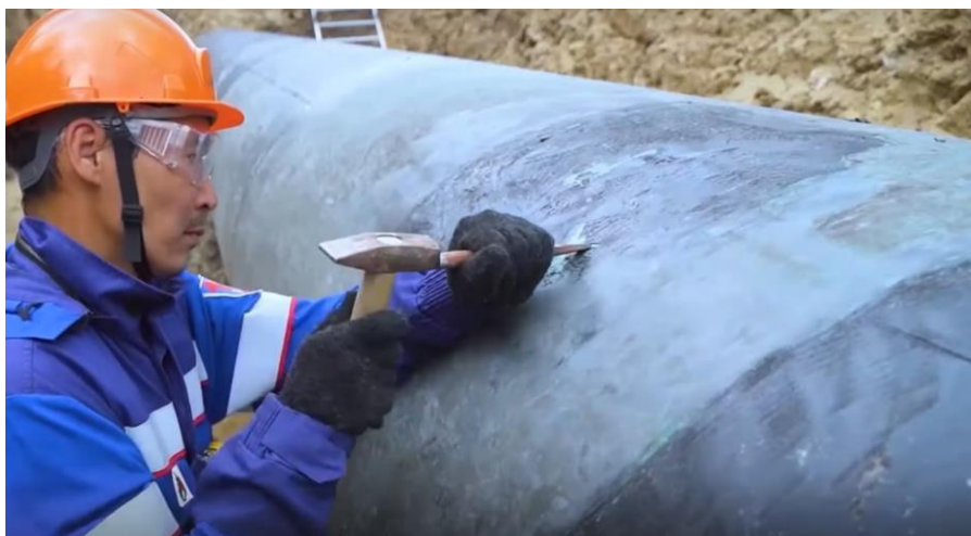
Рисунок 3 – Снятие изоляционного покрытия
