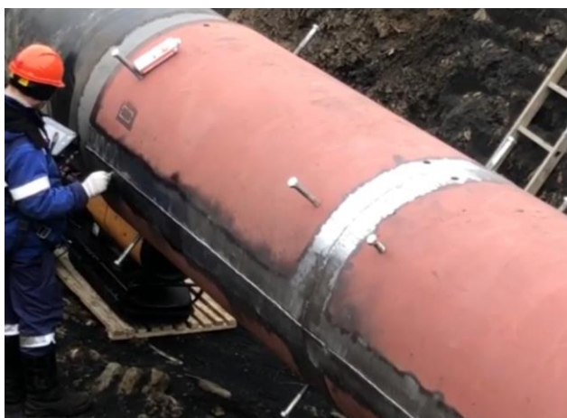
Рисунок 7 – Сварка составной муфты
