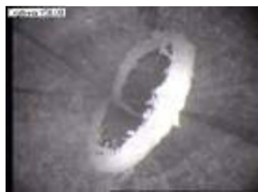
Рис. 2. Посторонний предмет в скважине
