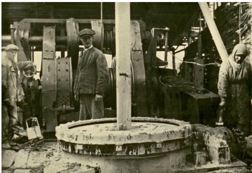
Рисунок 2 – Бурение газовых скважин на Казалинском месторождении 1943 года [1]
