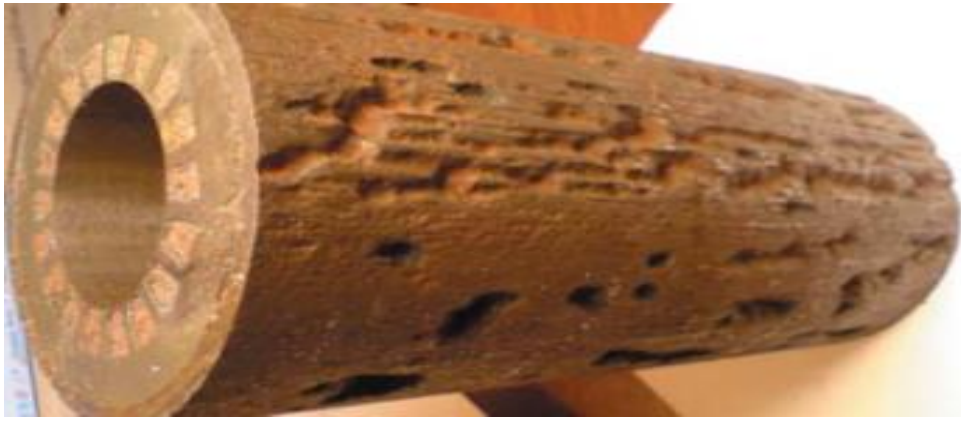
Рисунок 2.5 - Язвенно-канавочная коррозия корпуса ПЭД
