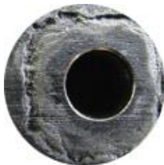
Рисунок 1.4 - Местная щелевая коррозия в хлоридсодержащих средах
