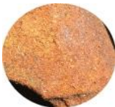
Рисунок 1.1 - Сплошная (общая) коррозия
