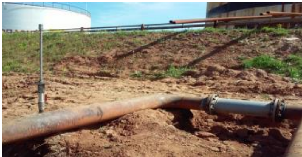
Рисунок 2.22 – Проведение опытно-промысловых испытаний
