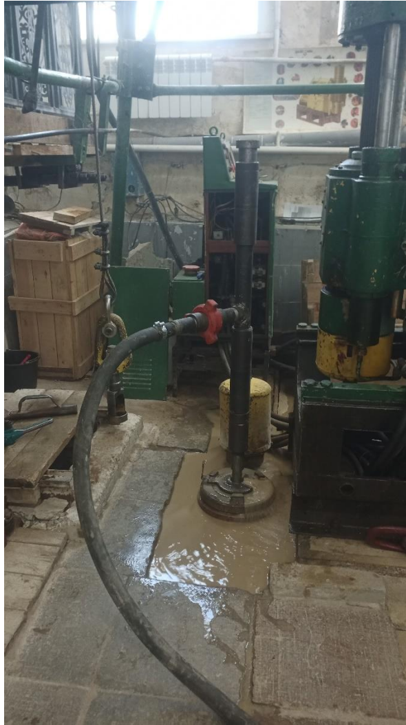
Рисунок 4.16 – Закачка раствора в скважину
