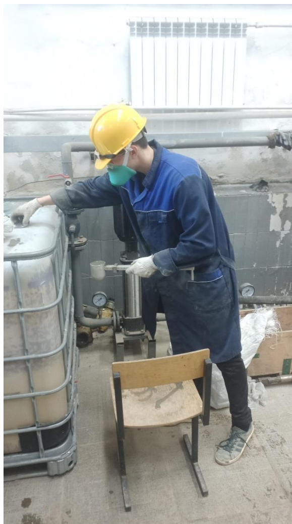
Рисунок 4.15 – Контроль параметров цементного раствора
