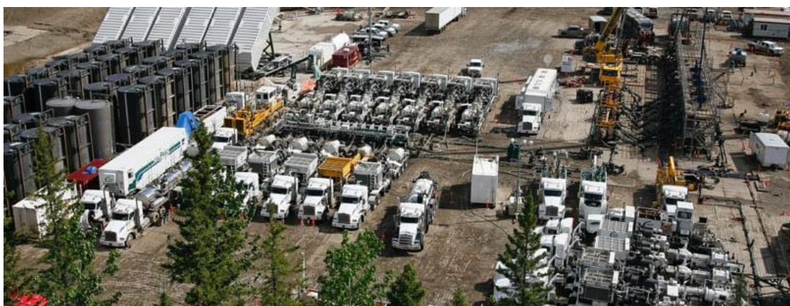
Рисунок 11 – Технологическое оборудование флота ГРП после расстановки и монтажа на кустовой площадке
