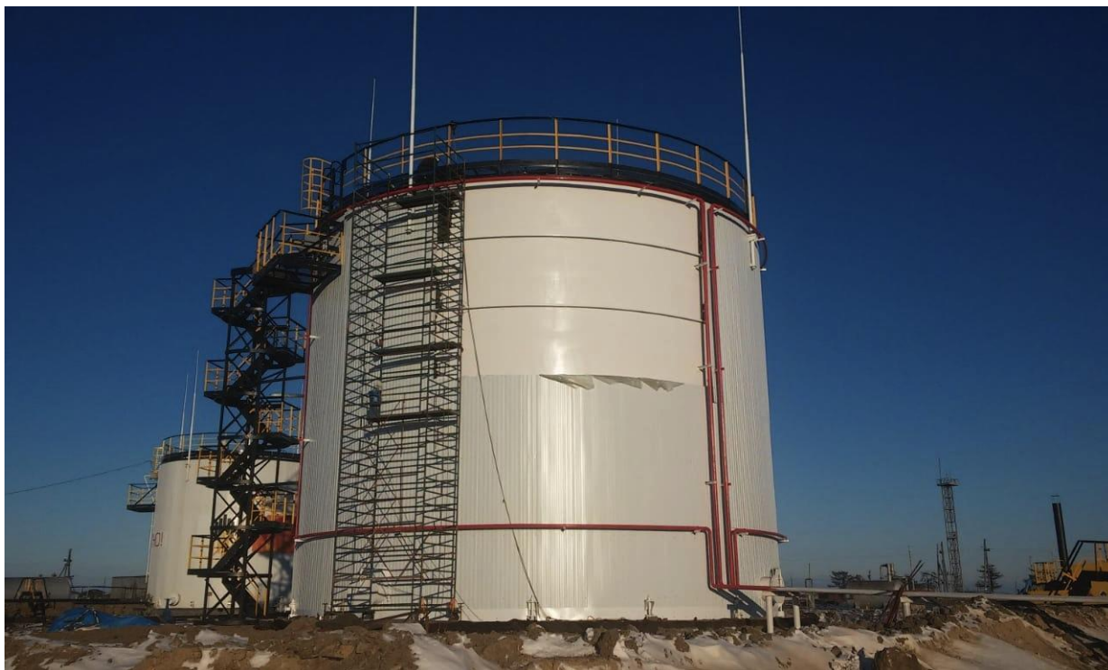
Рисунок 7 – Резервуар вертикальный стальной РВС-2000
