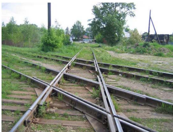
Рис. 1. Трамвайно-железнодорожные глухие пересечения: сверху – схема косоугольного железнодорожного пересечения; снизу – иллюстрации сварных сборных трамвайно-железнодорожных пересечений
