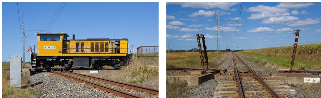
Рис. 2. Разводное железнодорожное пересечение без обустройства крестовин (Австралия): слева – сведенное для пропуска поезда в поперечном направлении; справа – разведенное для пропуска в продольном направлении
