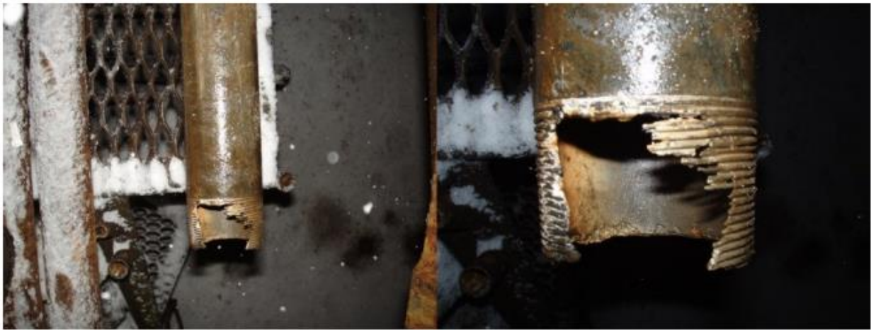
Рисунок 23 — Сквозная коррозия насосно-компрессорной трубы [10]
