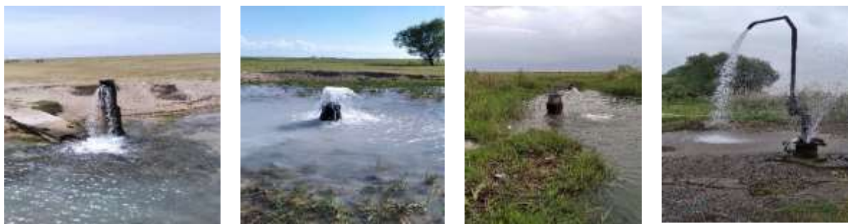
Рис. 2. Состояние отдельных самоизливающихся скважин
