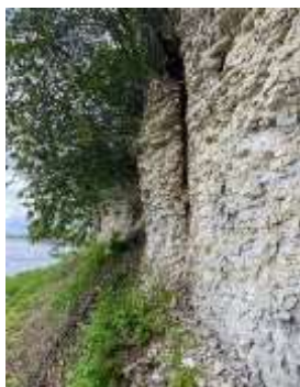
Рис. 2. Заполнение трещины дресвяно-щебнистым материалом
