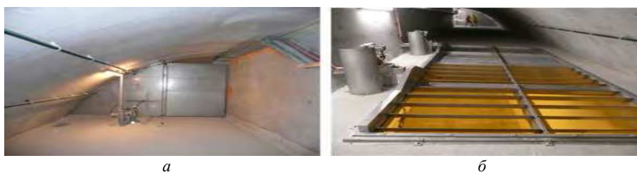
Рис. 1. Пример моторизованной заслонки, используемой для нагнетания свежего воздуха (б) и разделительной стенки воздуховода (а)
