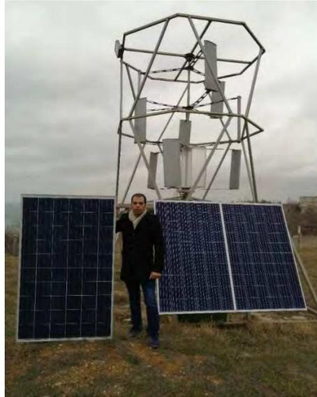
Рис. 3. Ветер / солнечная гибридная система питания на полигоне Сев ГУ на турбазе Горизонт
