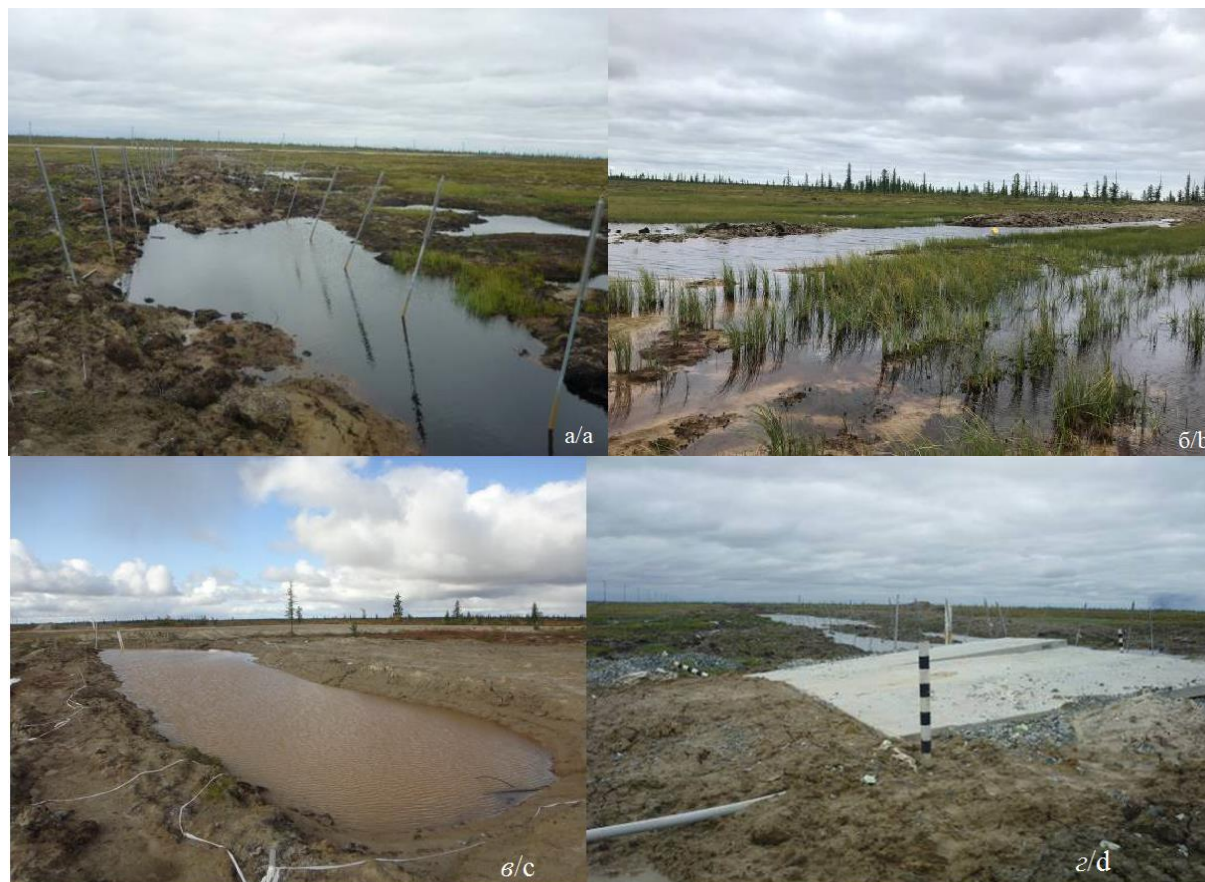
Рис. 4. Геологические процессы по трассе трубопровода: а) заболачивание; б) обводнение; в) термокарст; г) морозное пучение
