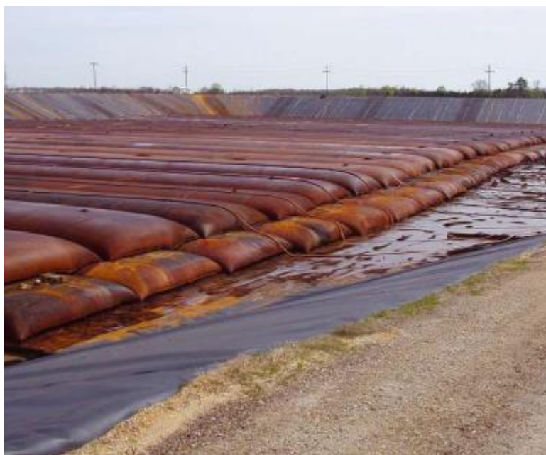
Рис. 5. Общий вид сложенных геотубов (Geotube) [25]
