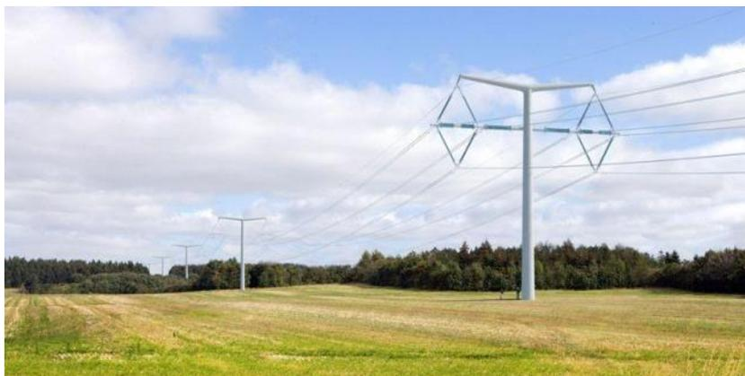
Рис. 1. Вариант опоры ЛЭП *Bystrup*
