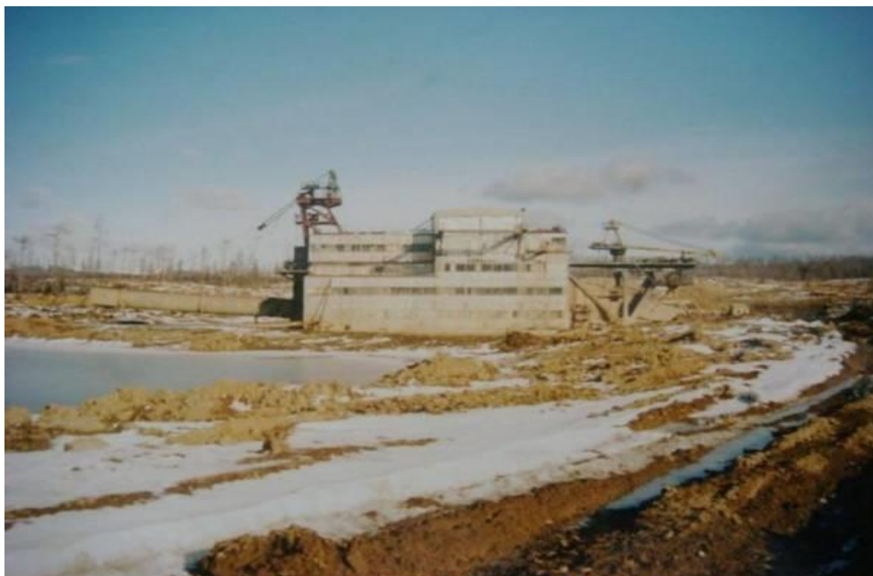
Рисунок 2.4 – Последствия работы драги
