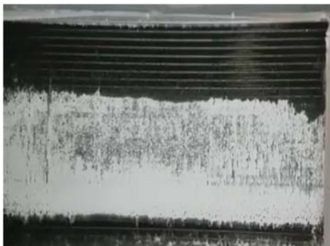
а – Вытяжной калорифер с инеем
