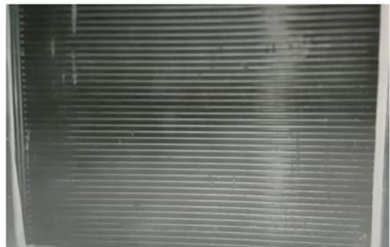
б – Вытяжной калорифер после разморозки
