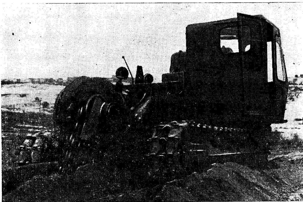
Рис. 1. Общий вид установки для резания мерзлых грунтов.
