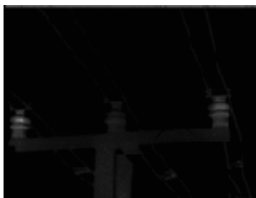
Рис. 6. Повышение температуры опорных изоляторов
