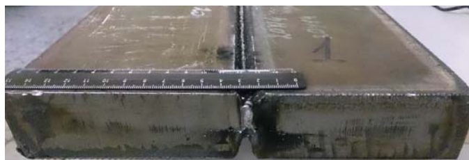
Внешний вид сварного соединения
