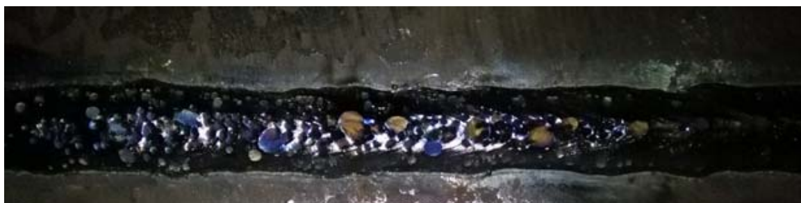
Рис. 2. Качество поверхности сварного шва при сварке с использованием фракции 2,5 – 5 мм
