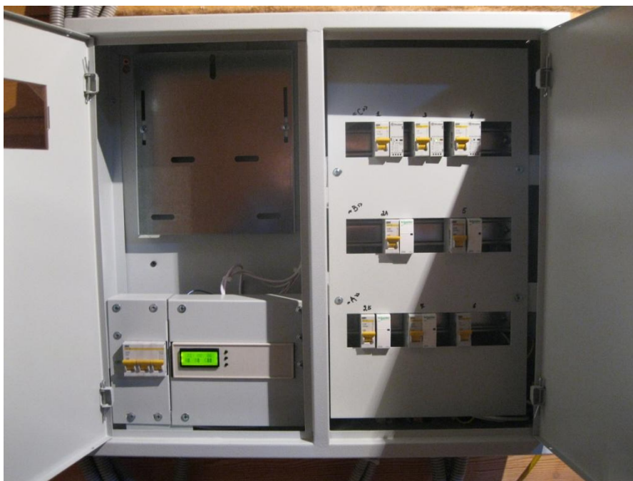
Рис. 3. Реле отключения неприоритетной нагрузки в собранном щите автоматики внизу слева (частный дом, пос. Росинка)
