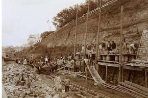
Рис. 3. Строительство подпорной стенки 1885 г.
