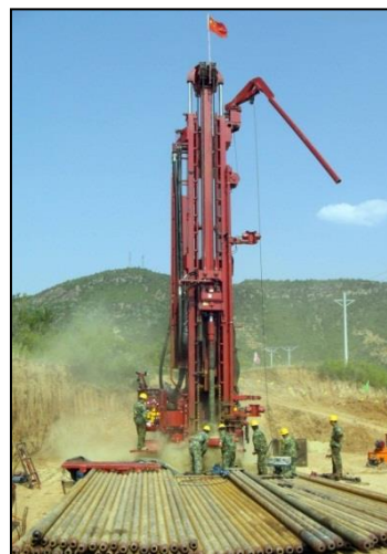
Рис.2. Мобильная буровая установка T130XD
