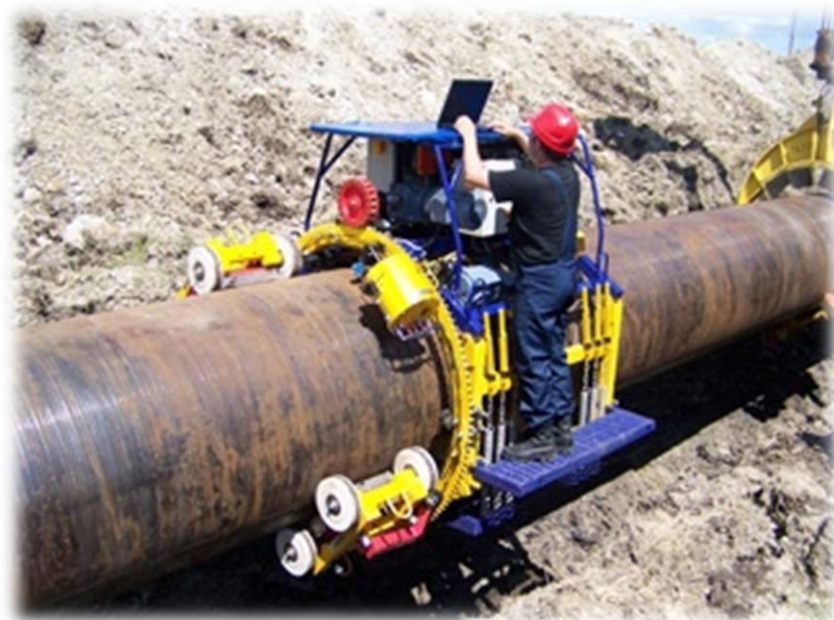
Рис. 1.9 Очищенная поверхность трубы
