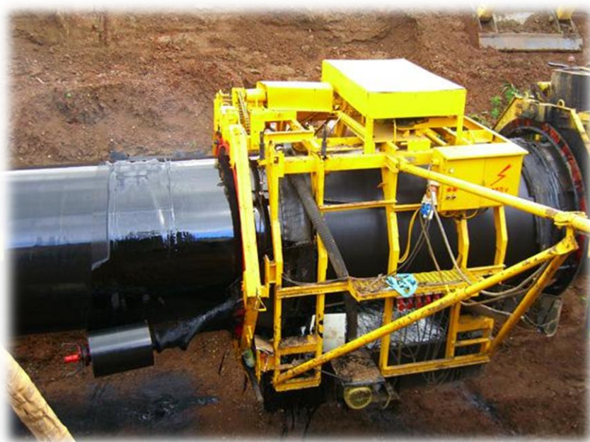
Рис. 1.10 Нанесение нового изоляционного покрытия
