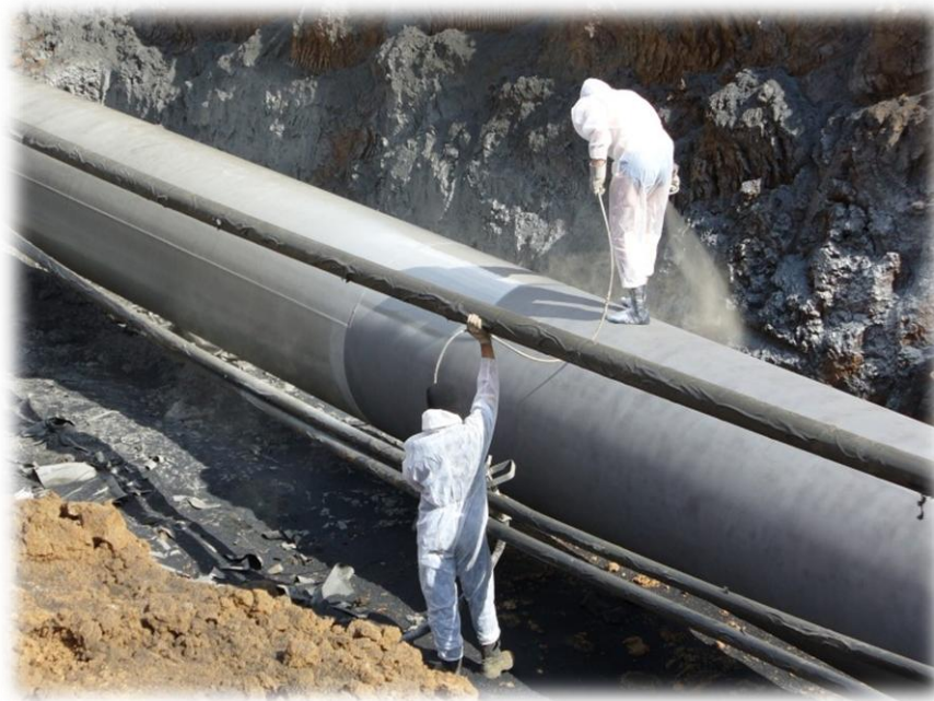
Рис. 1.8 Участок очищенной трубы
