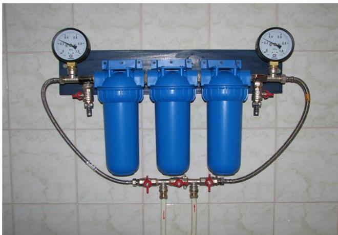
Рисунок 1. Общий вид водоочистной установки
