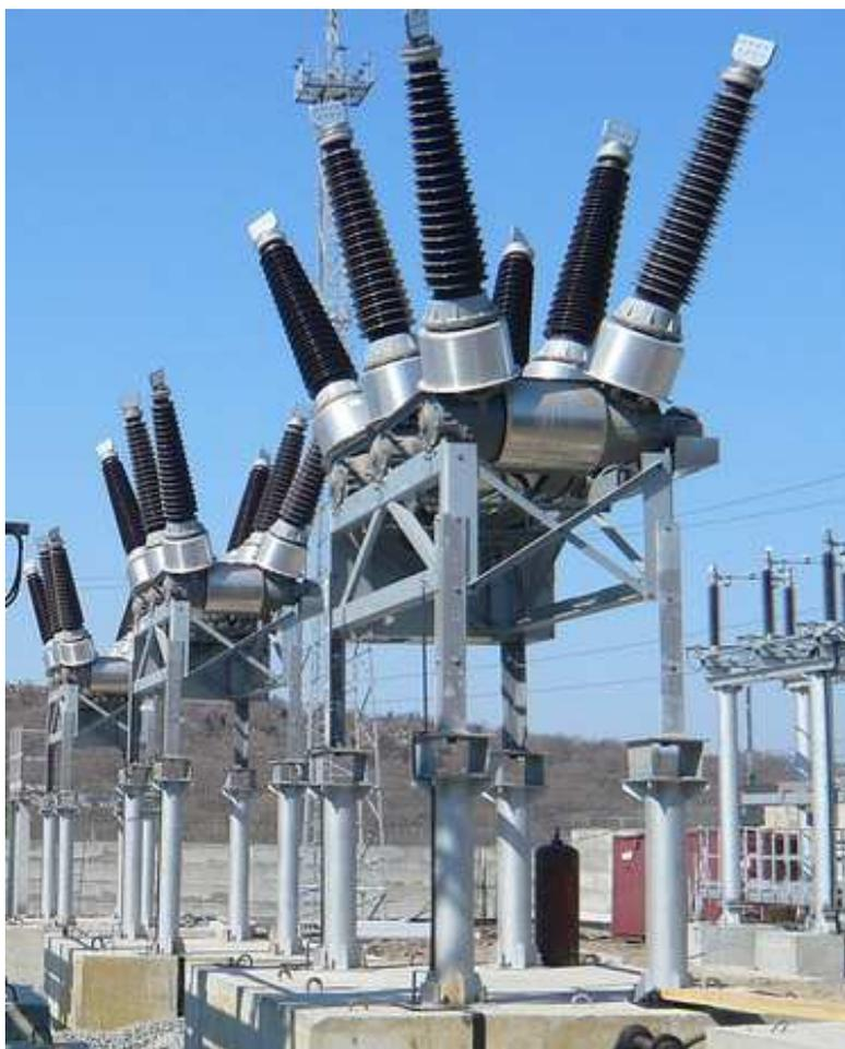
Рисунок 12 -Элегазовый баковый выключатель 110 кВ с фарфоровой изоляцией вводов типа ЗАР1DT-145/ЕК.
