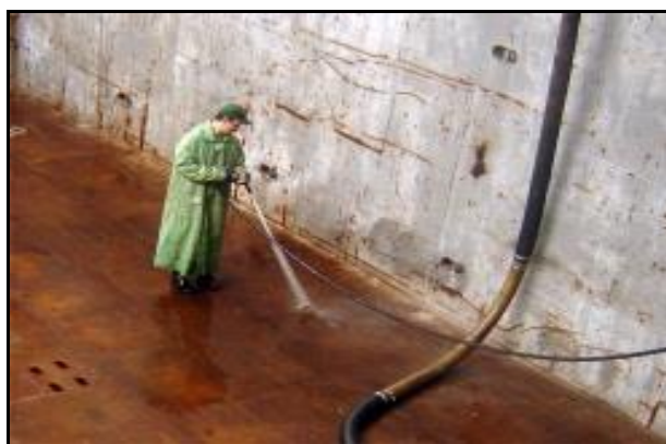
Рисунок 3.1 - Ручная очистка резервуаров
