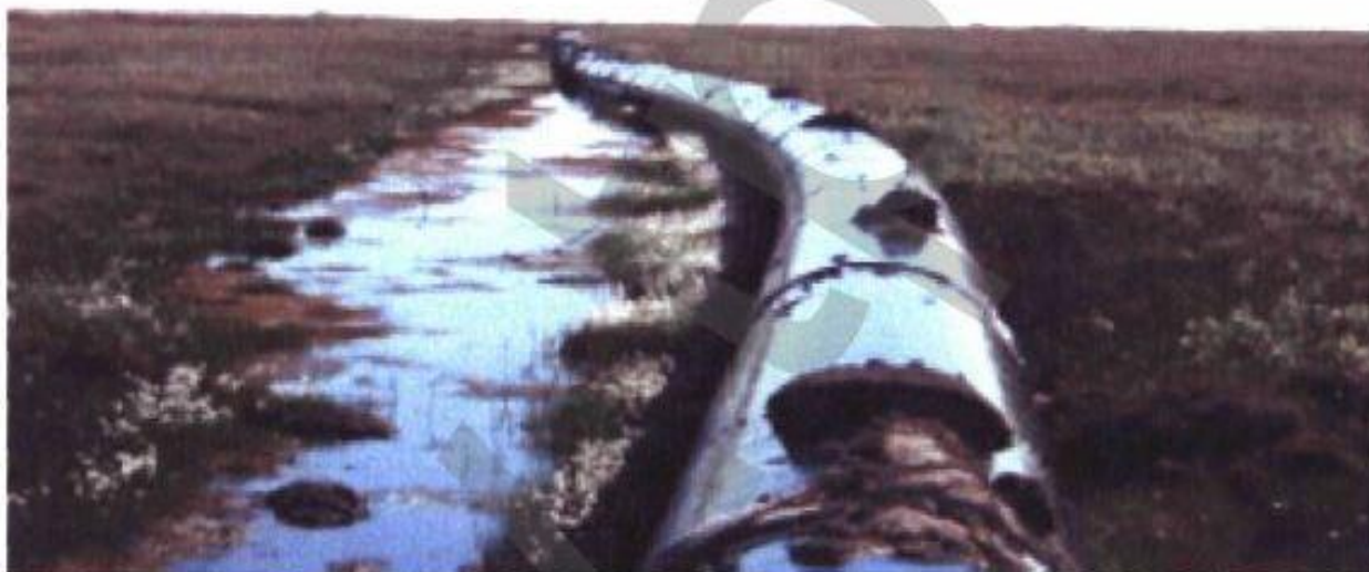
Рисунок 5 – Изгибные деформации газопровода при всплытии под действием термокарста
