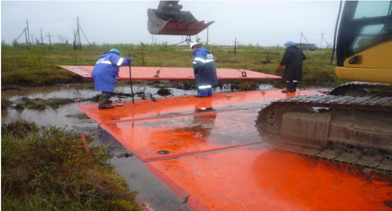
Рис.2.4 Использование временных дорог в болотистых местностях
