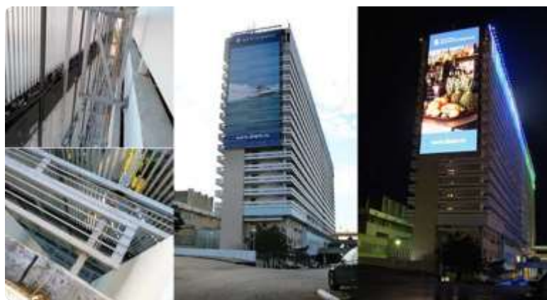
Рисунок 12 – Каркасный реечный МФ
