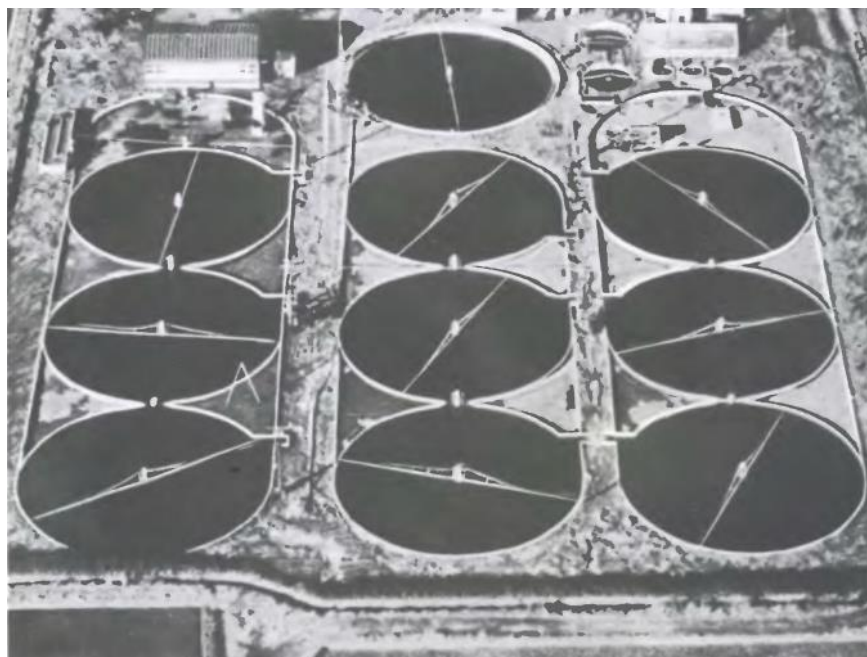
Рисунок 1.2 – Установки для выращивания хлореллы под открытым небом
