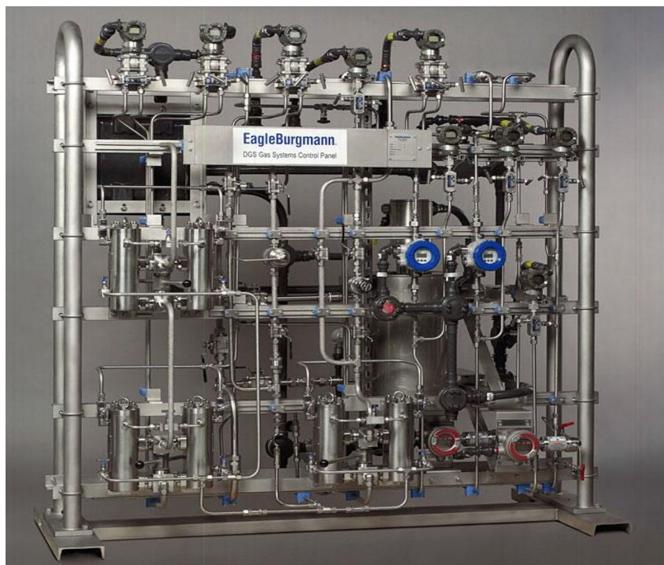
Рисунок 3 - Панель управления СГУ фирмы «EagleBurgmann»
