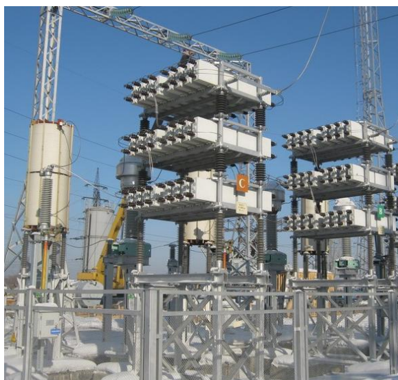
Рисунок 1.4 - Силовые конденсаторы
