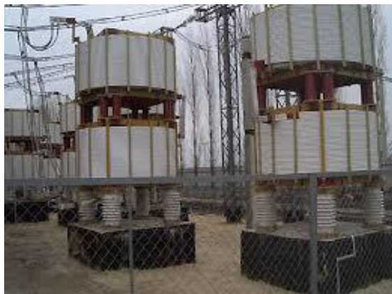
Рисунок 1.5 – Шунтирующий реактор
