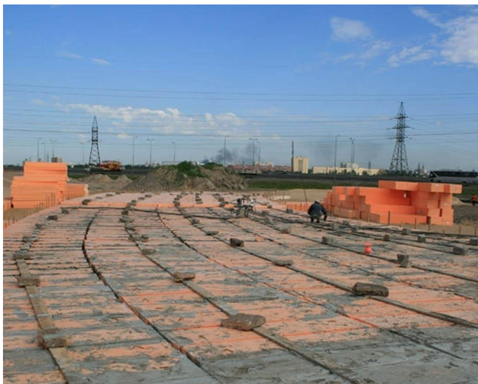
Рисунок 5 – Утепление дорожного полотна ПЕНОПЛЕКСОМ
