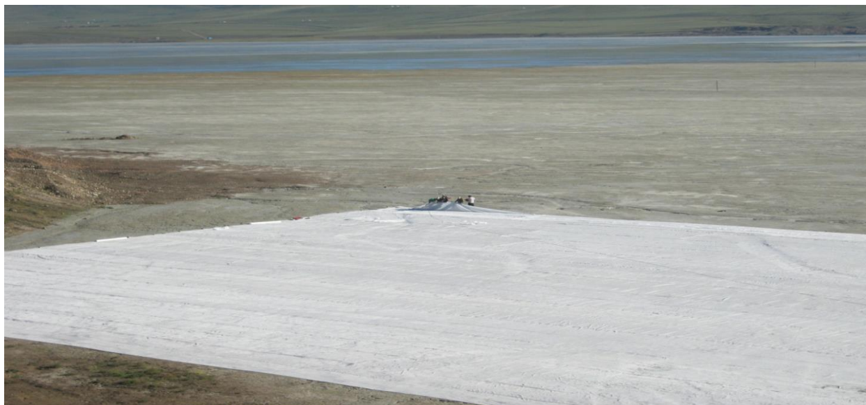
(Компания “Эм Эн Эм Си Энд Си” накрыли 1 гектар участка синтетической сеткой.) Рисунок 4.18[38]
