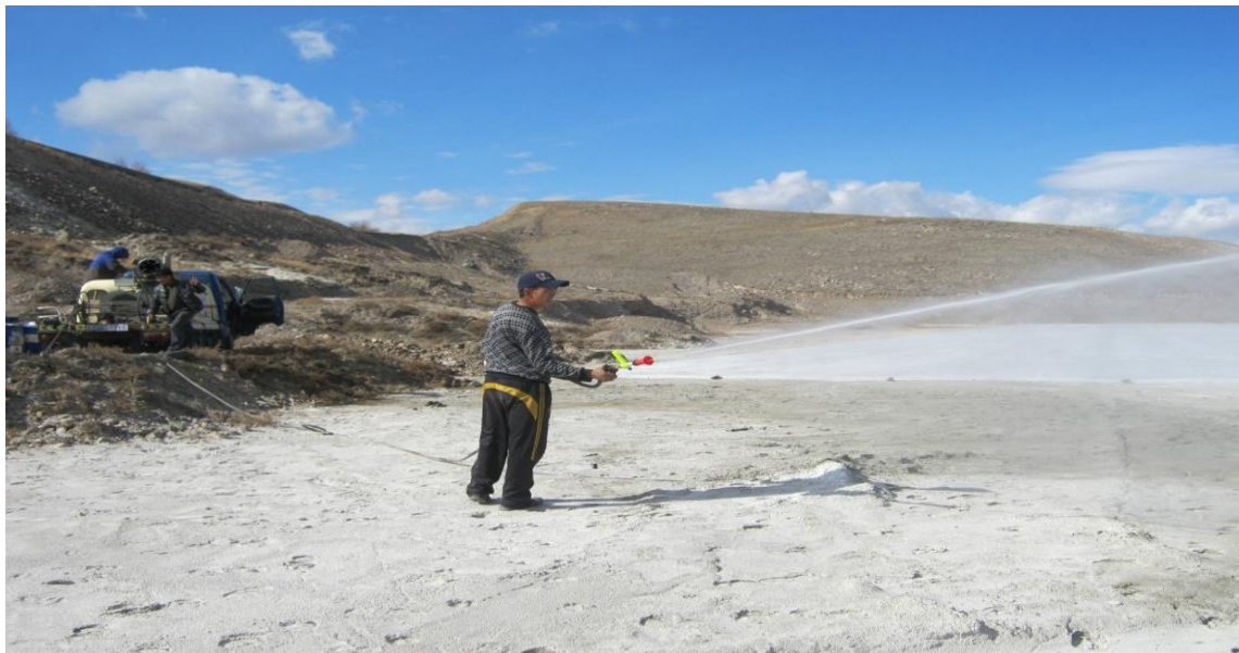
(Монгольская Компания “Монхимо” разбрызгивали полимерные соединения, которые сами разработали на площади 1300 м 2 ). Рисунок 4.17[38]
